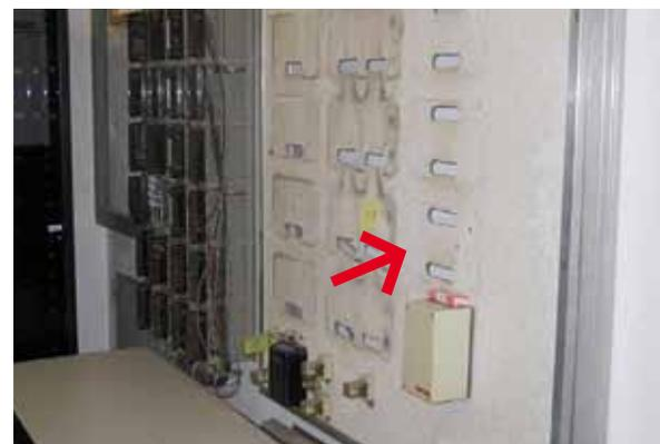
Bild 1: Asbesthaltige Leichtbauplatte
